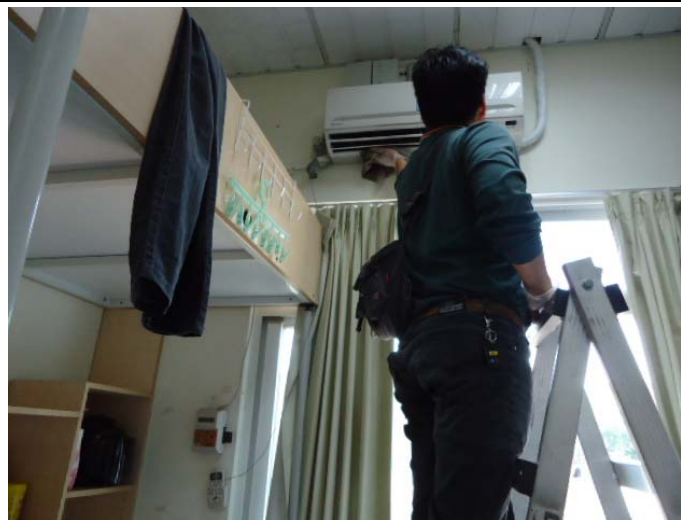
10.裝回濾網與面板後再次清潔擦拭與運轉檢測
